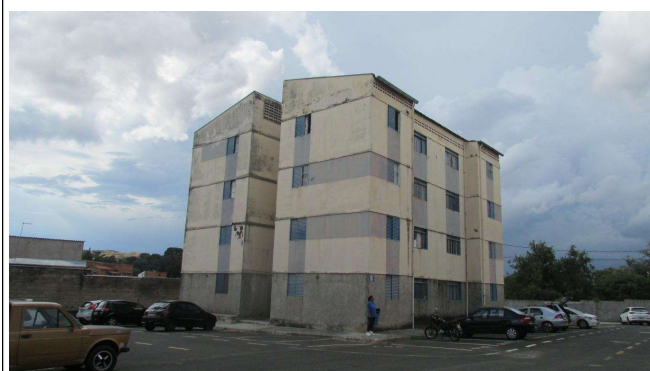
Foto 10 – Vista geral do Condomínio Residencial Fernão Dias.
