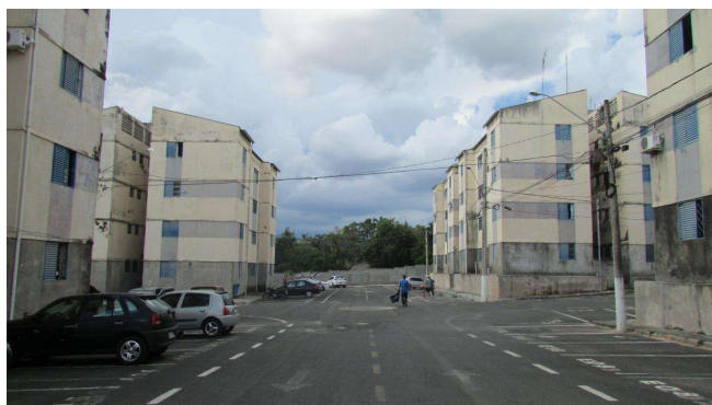
Foto 07 – Vista geral do Condomínio Residencial Fernão Dias.
