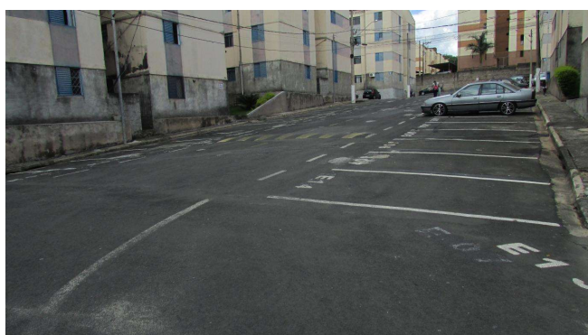
Foto 09 – Vista geral do Condomínio Residencial Fernão Dias.
