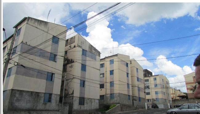
Foto 08 – Vista geral do Condomínio Residencial Fernão Dias.
