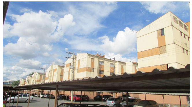
Foto 02 – Vista geral do Condomínio Residencial Borba Gato.
