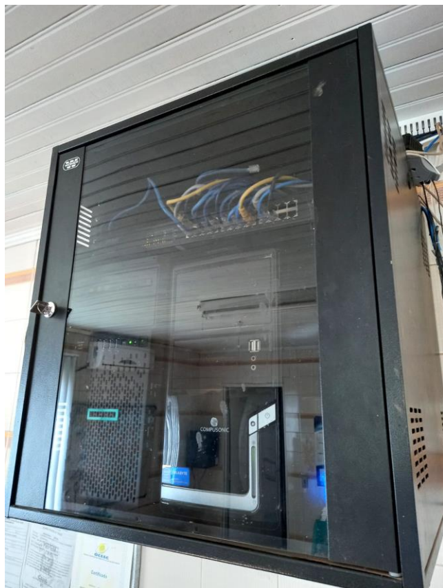
Cód. 16 - Rack com Servidor e Rastreadores
